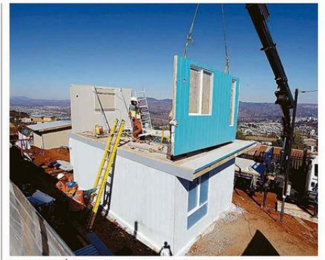
CONSTRUCCIÓN ES UNO DE LOS SECTORES COMPLICADOS A LA FECHA.
