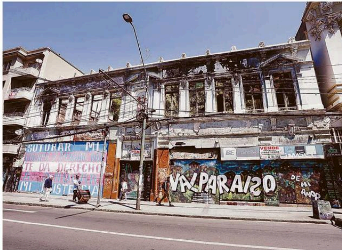
EL EDIFICIO DE CALLE CONDELL DONDE ESTABA EL BANCO ESTADO Y EL LOCAL FIESTA FELIZ SIGUE ABANDONADO.
