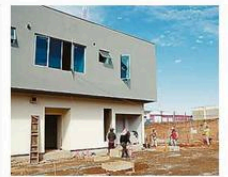
OBRAS REGISTRAN AVANCE.
